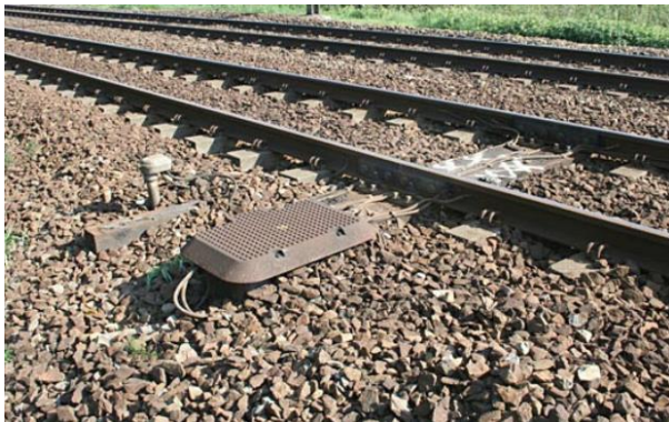
Afbeelding 15. Railspoel
