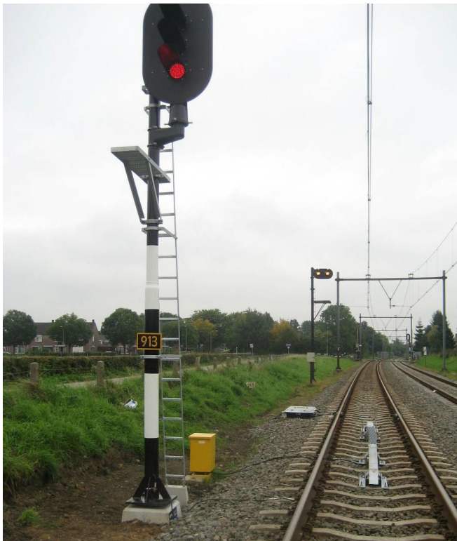
Afbeelding 9. Plaatsing krokodil
